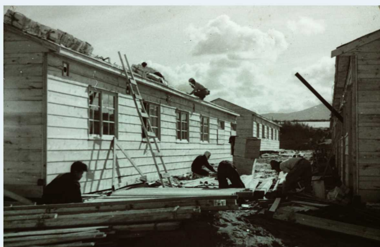
大浜の木造仮設住宅の建設（バラック住宅）
