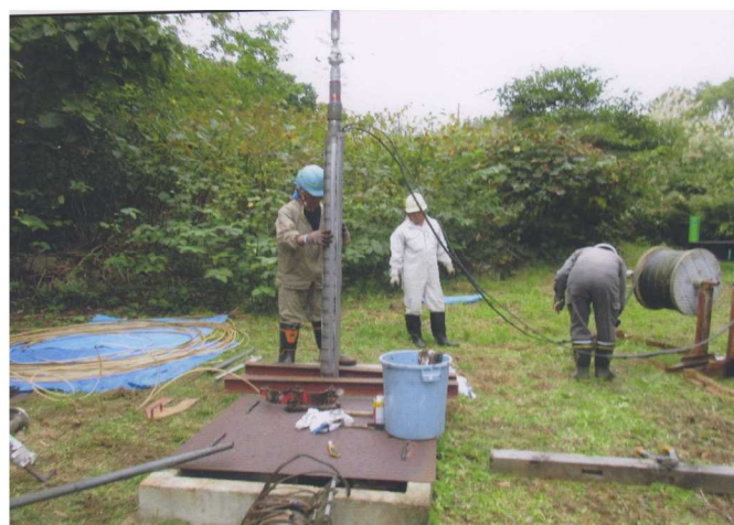
温泉水中ポンプの設置（引揚）作業。
