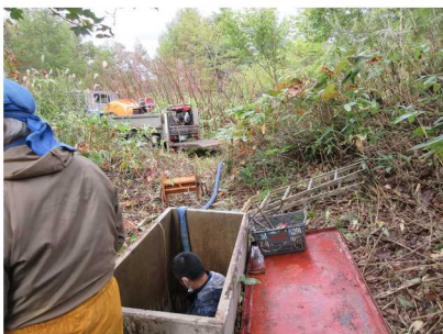
ピット内での作業の様子
