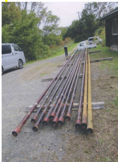
グラスファイバー製の揚湯管。9mを22本つなぎ、198mになる。
